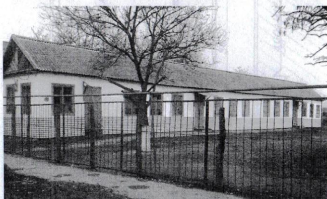
Здание 1960г, корпус поведенный
